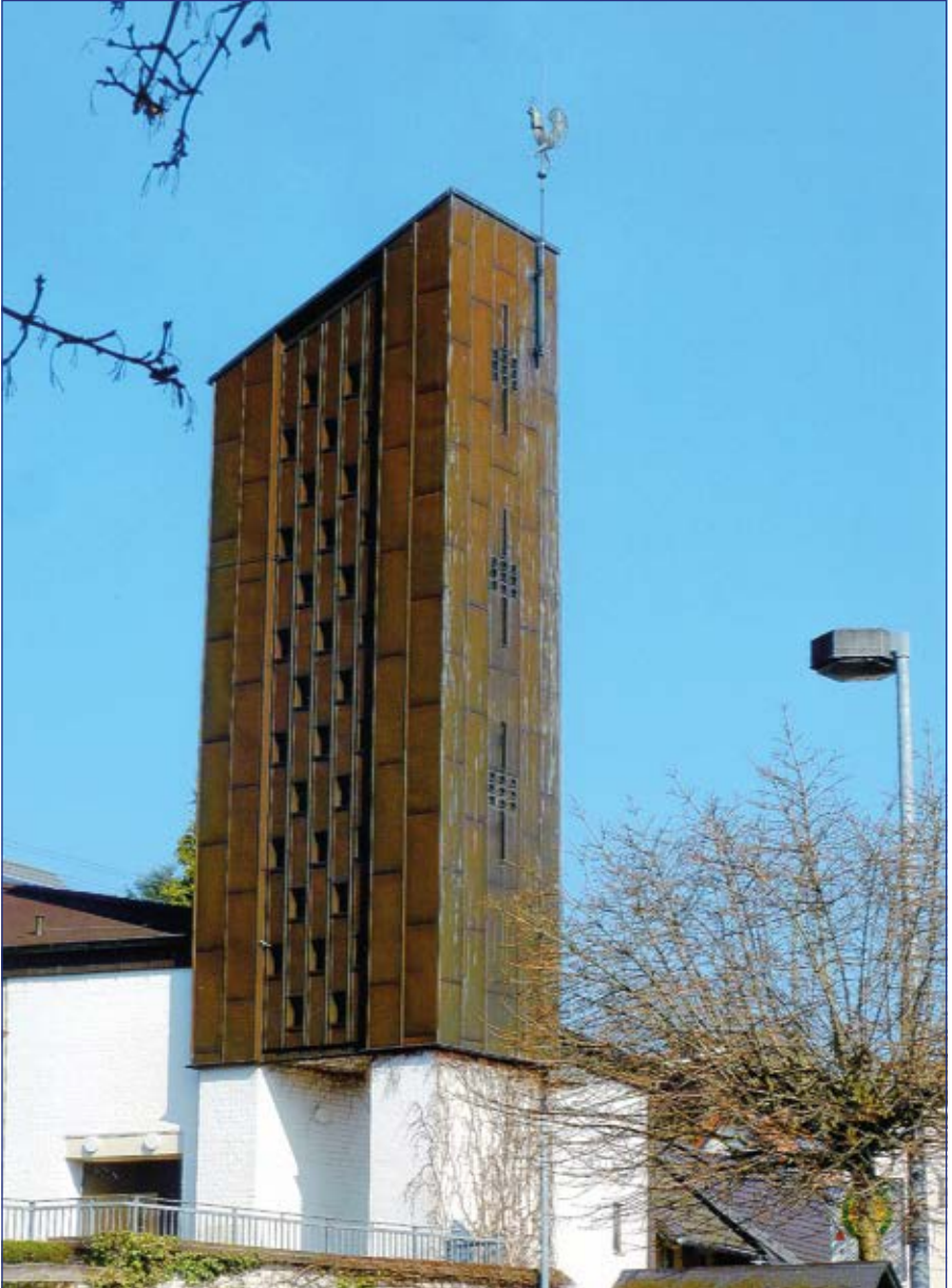
Die 1985 gebaute Kirche „St. Mariä Himmelfahrt“ ist das bedeutendste christliche Denkmal in Bröl
